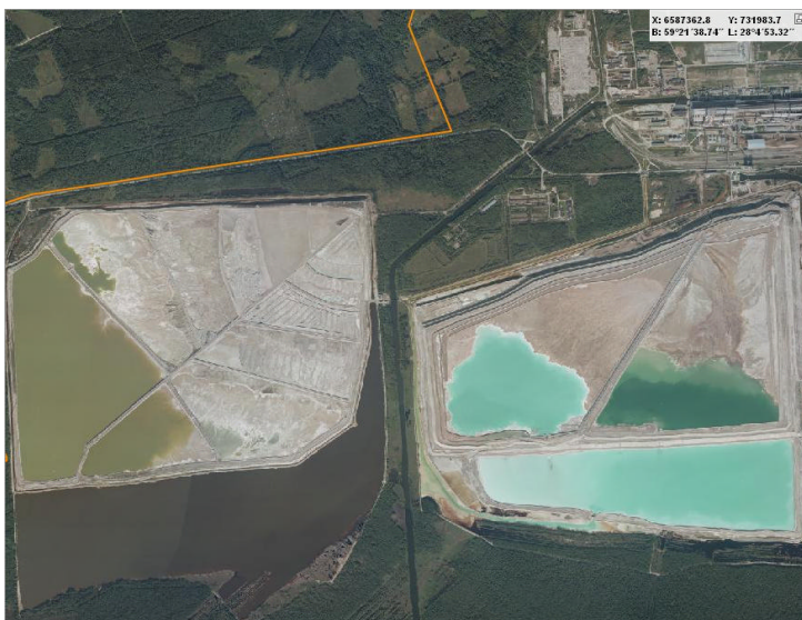
Foto 2. Balti soojuselektrijaama tuhaväljad Narva edelaosas.
